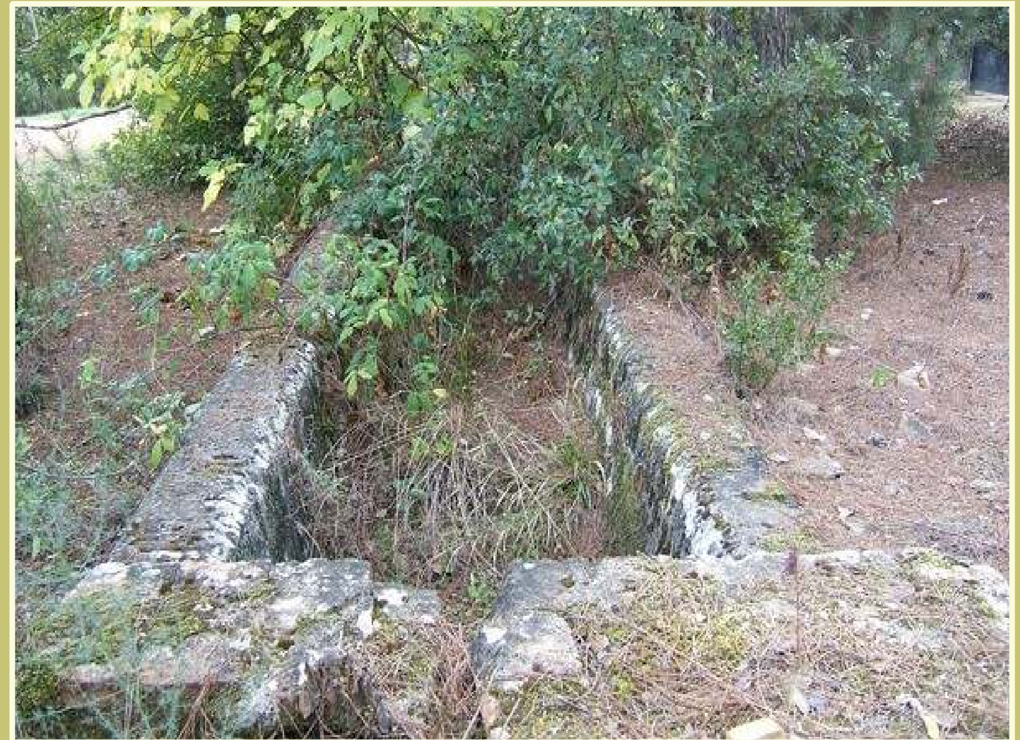
Fuente y abrevadero sobre Vía Pecuaria en el descansadero situado en la proximidad de Puerto Artarfi
